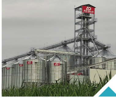
Adana Sarılar Lidaş 50bin Ton Çelik Silo
